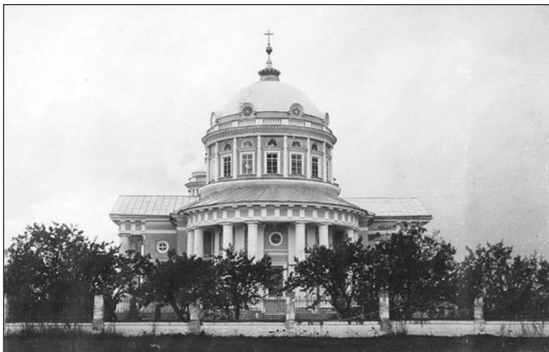
Шкинй. 1915 г. Церковь Святого Духа, построена Гаврилой Ильичем Бибиковым в 1801, многие элементы здания совпадают с подобными в здании храма Гребневской Богоматери (1785-1791) в селе Гребнево (1785-1791), центре имения Бибиковых в Богородском уезде.
